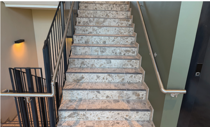
Flislagte gulv og trappetrinn i oppgangen.
